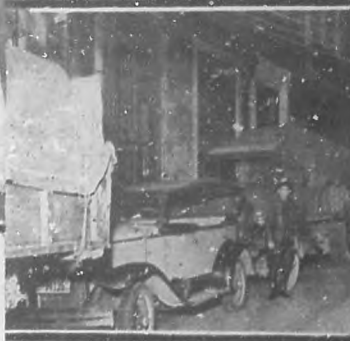
Un aspecto de los caminos del contrabando de azúcar de la Casa Boret, poco después de haber sido sorprendido en la Carretera Central por las autoridades policíacas.
